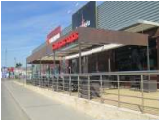
Propuesta zona RESTAURACIÓN MEDIANAS.
