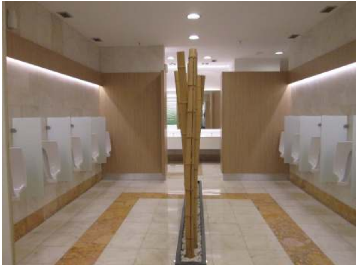
Actuaciones: Colocación de fenólicos blancos en cabinas inodoros, separador entre urinarios en cristal al acido, falso techo en pladur continuo
