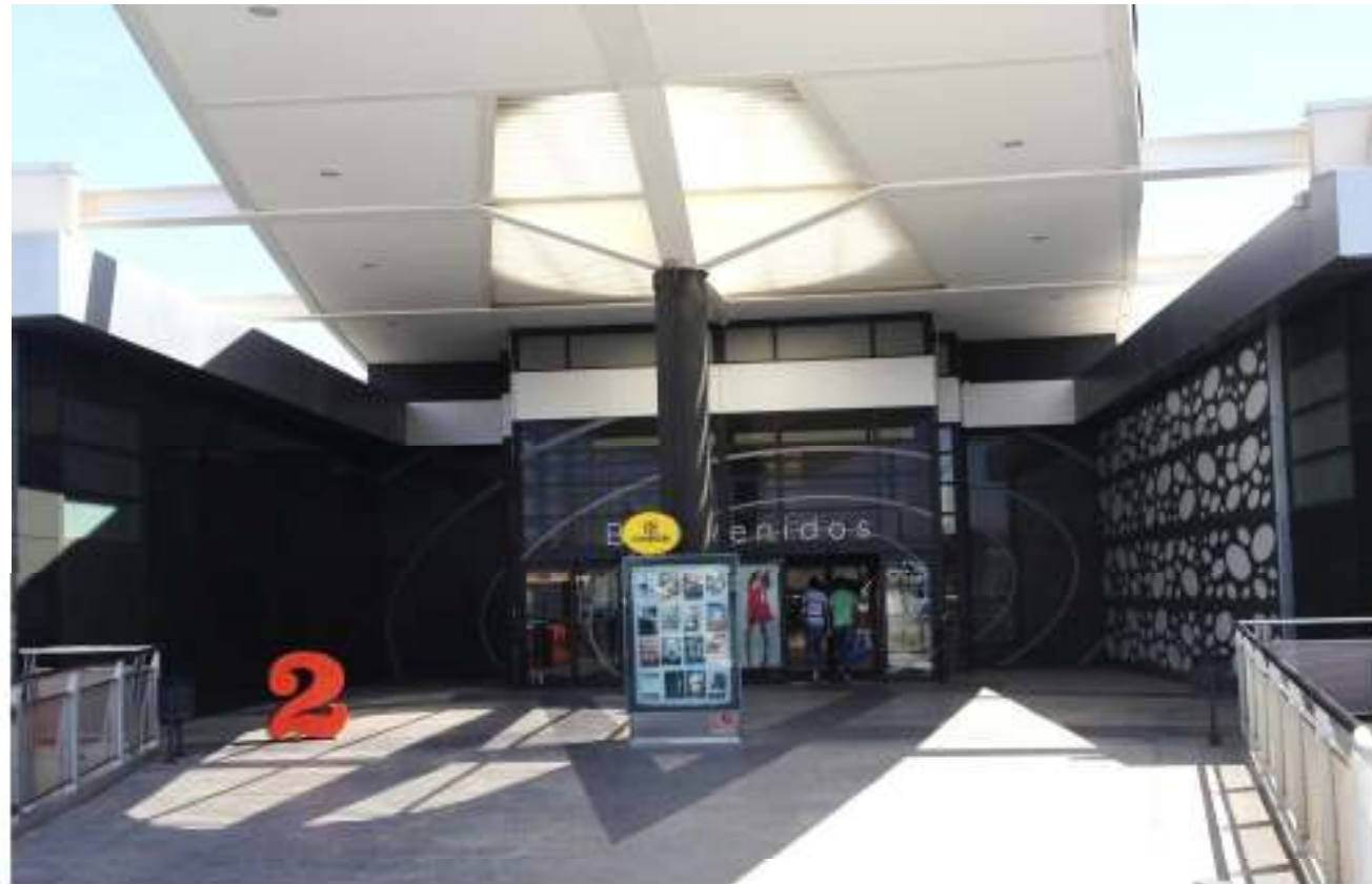
Actuaciones: Vinilado sobre muro cortina para remarcar entradas sobre fachada. Muro con óvalos iluminados. Número en color para señalar entrada. Cambio situación rótulo.
