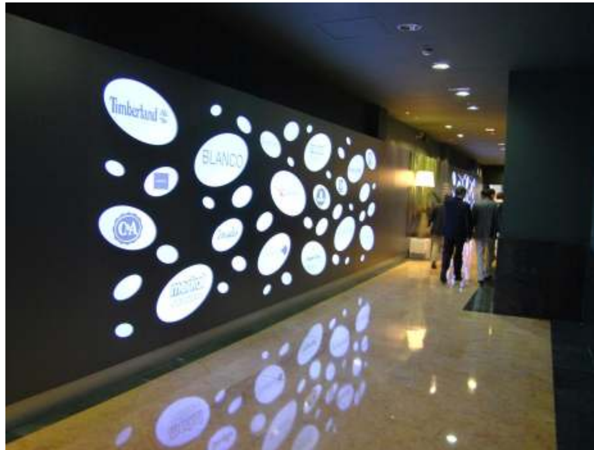
Actuaciones: Colocación de muro luminoso en DM lacado en alta resistencia, ovalos de policarbonato blanco retroiluminado, pintura de paramentos horizontales y verticales en color gris
