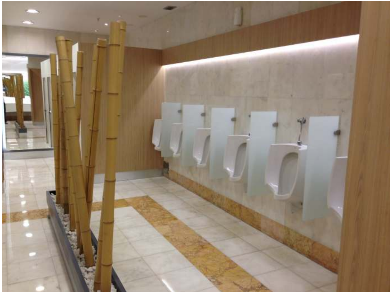
Actuaciones: Colocación de fenólicos en madera clara, separador entre urinarios en cristal al ácido, falso techo en pladur continuo
