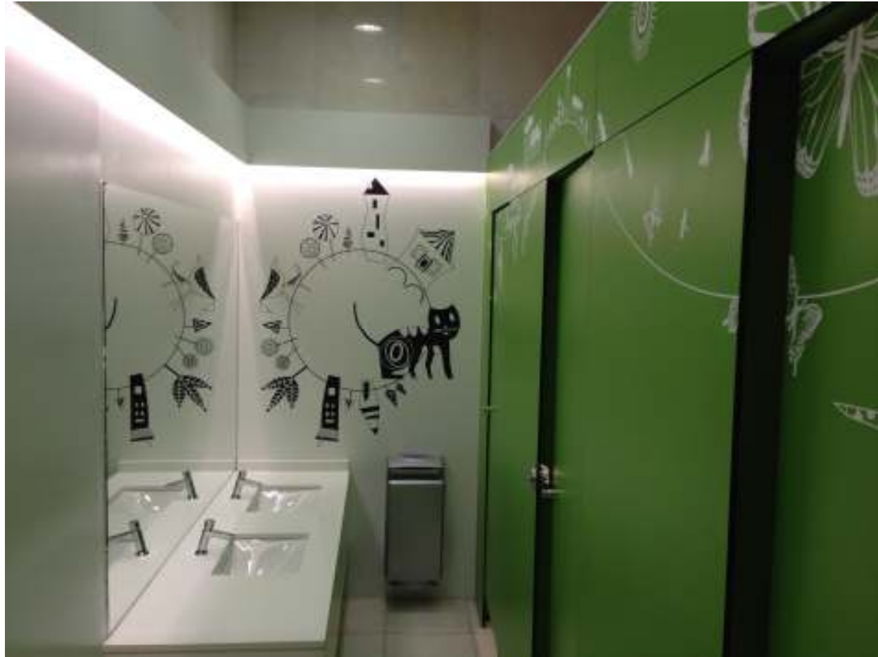
Actuaciones: Colocación de tablero fenólico para encimeras, techo pladur continuo y formación de candilejas. Vinilos con motivos de óvalos.
