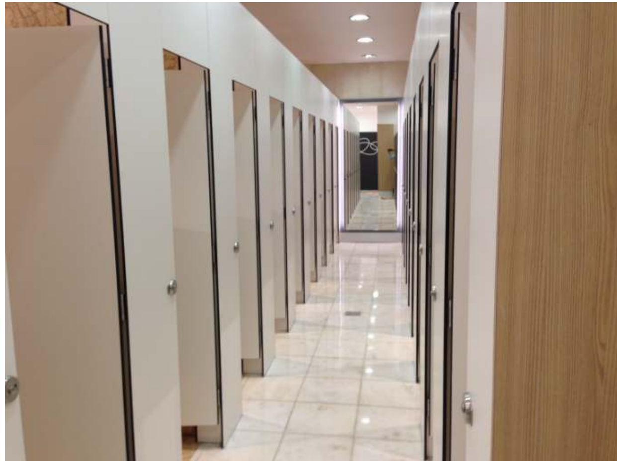
Actualizaciones: Colocación de tablero fenólico blanco en cabinas inodoros, cambio de lavabos y grifería, techo pladur continuo y formación de candilejas. Vinilos con motivos de óvalos
