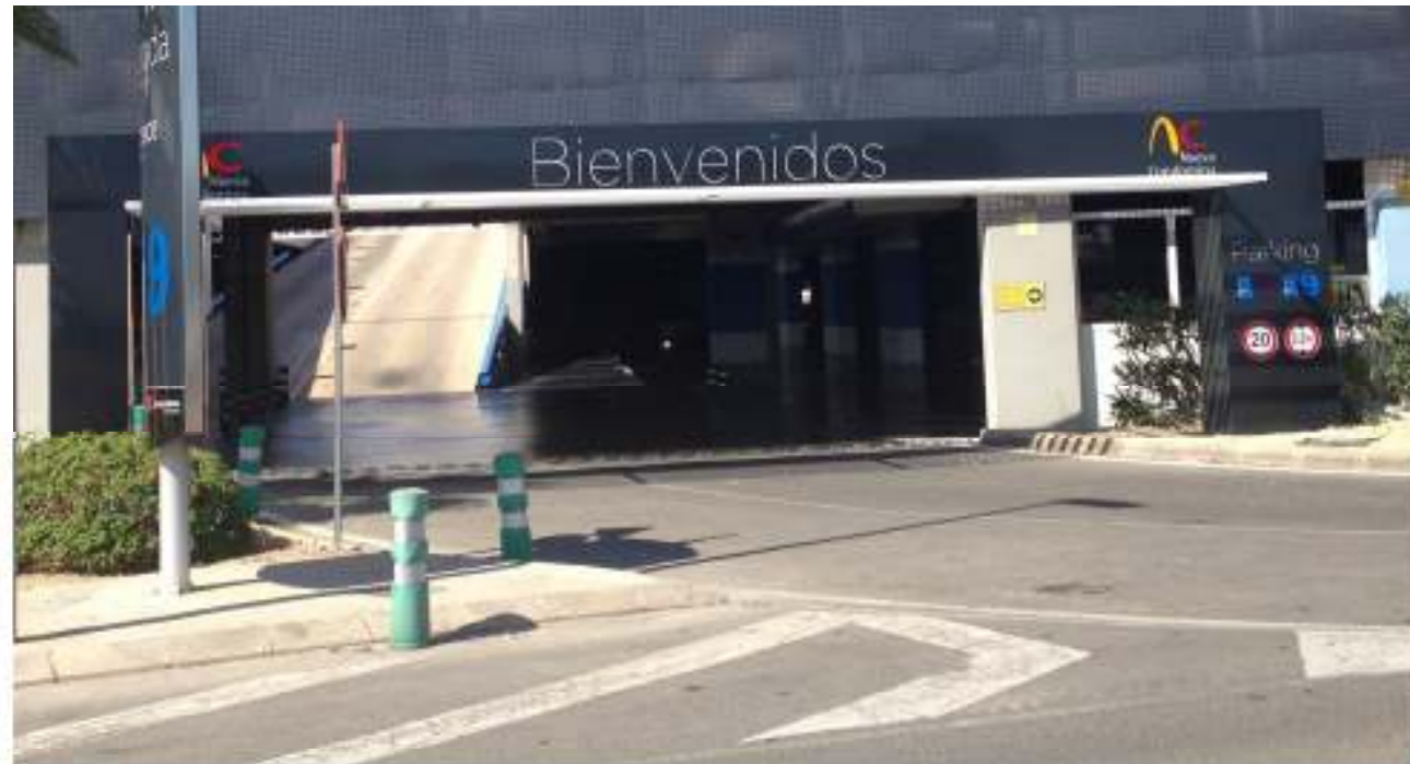
Actuaciones: Colocación de nueva señalética en parte superior de pórticos de entrada.
