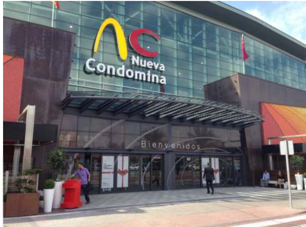
Actuaciones: Colocación pérgola de vidrio para enfatizar entrada principal. Intervención sobre terrazas para homogeneizarlas con imagen interior.
