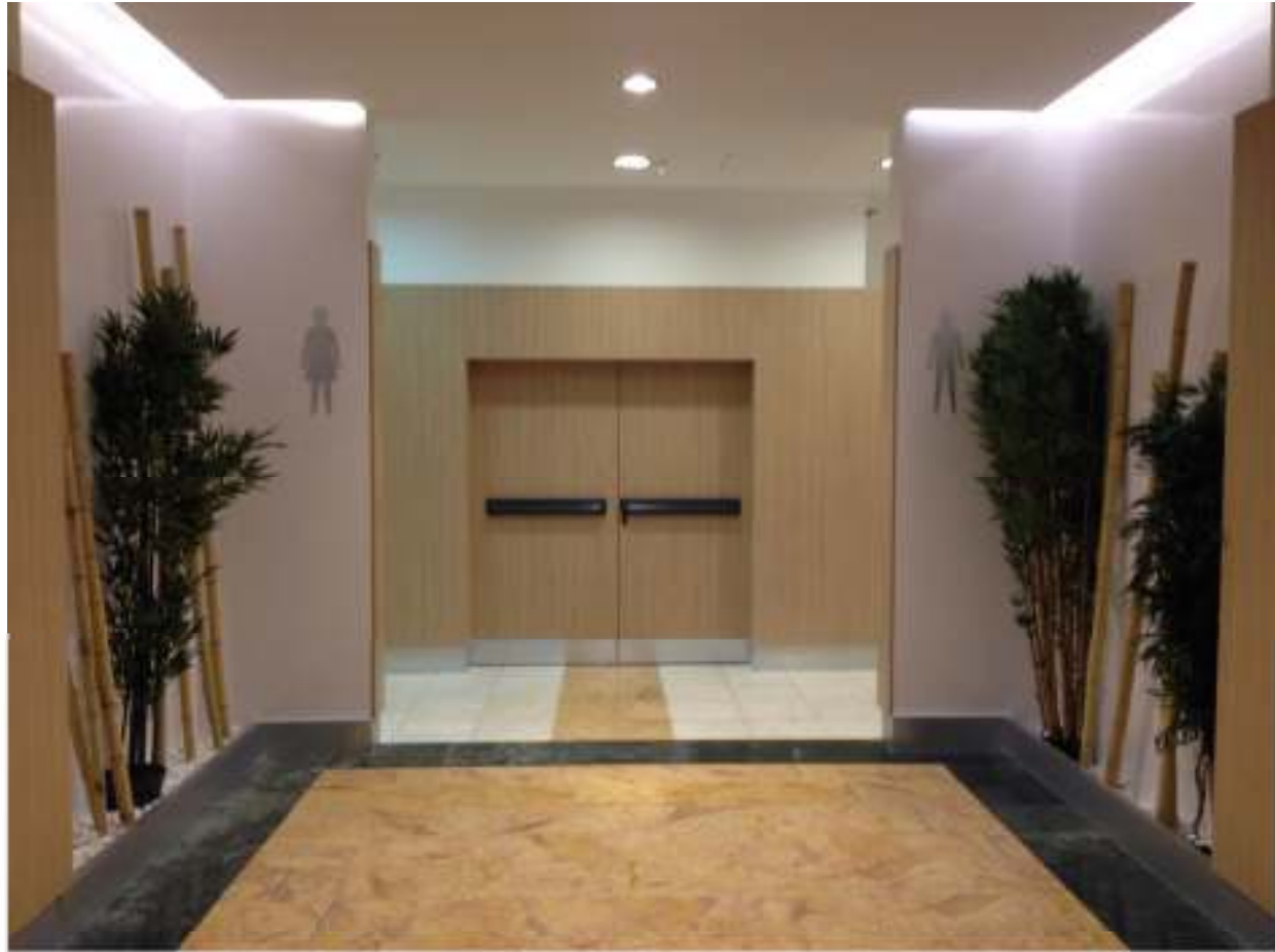
Actuaciones: Panelado de paredes de DM y chapado en roble, pintura de paramentos horizontales y verticales, colocación de vinilos con diferentes elementos de señalética USE
